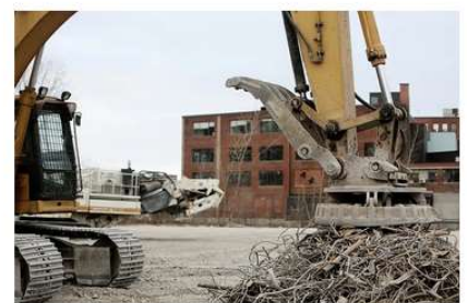
© Abb. 4 Mit einem Elektromagneten kann Metallschrott aufgenommen werden
