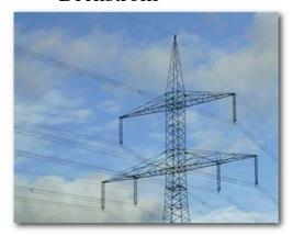
Betrachtet man Hochspannungsleitungen, so stellt man fest, dass die Leitungen nicht als Paare (Hin- und Rückleitung) sondern stets im "Dreierpack" auftreten
